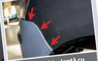
Bară neechivalentă cu probleme la montare
